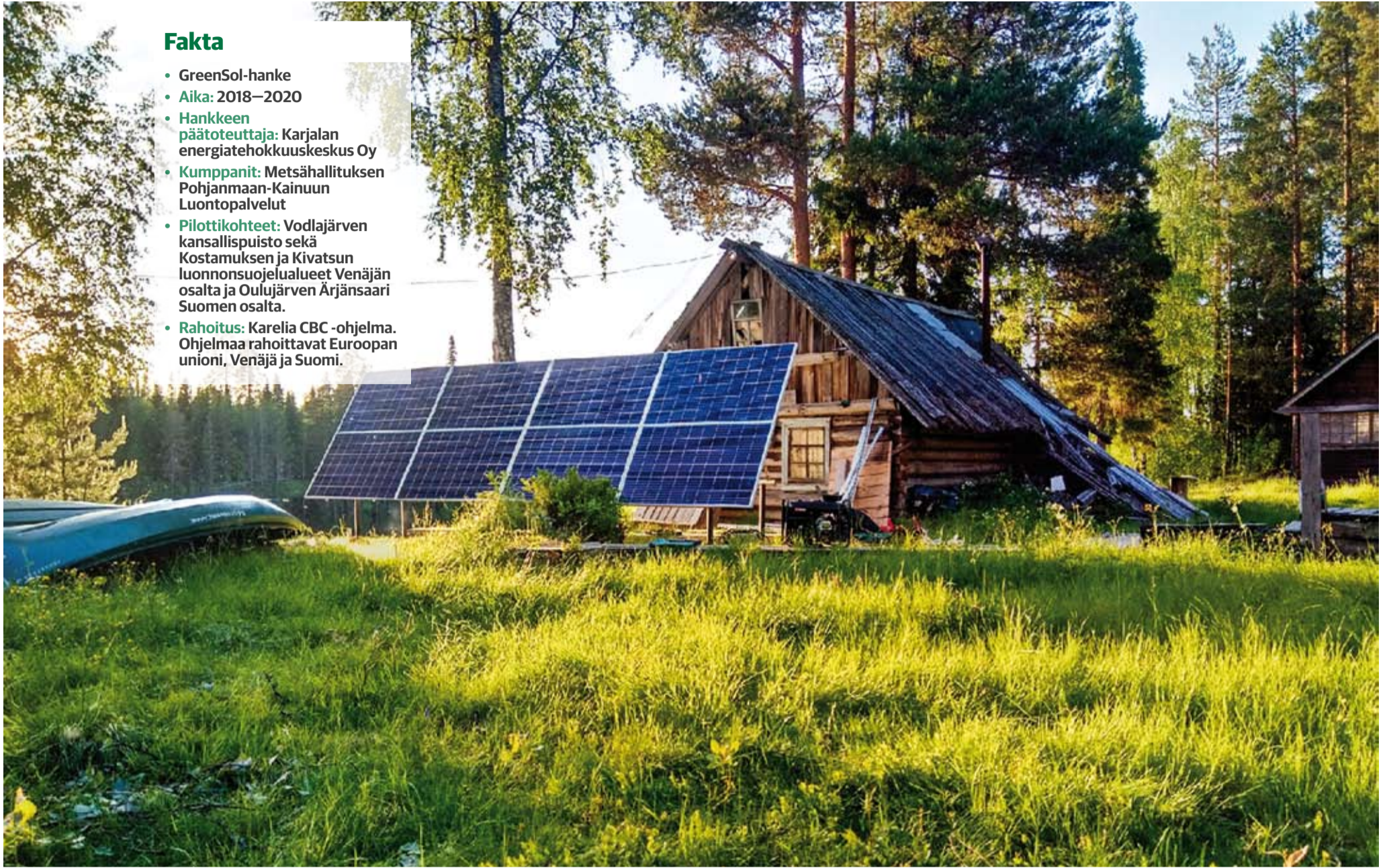
Aurinkopaneelit on asennettu Novguda-vartiopaikalle. Aurinkoenergiaa riittää valaistukseen, videolaitteiden toimintaan ja sähkölaitteiden lataukseen. KUVA: VODLAJÄRVEN KANSALLISPUISTO
